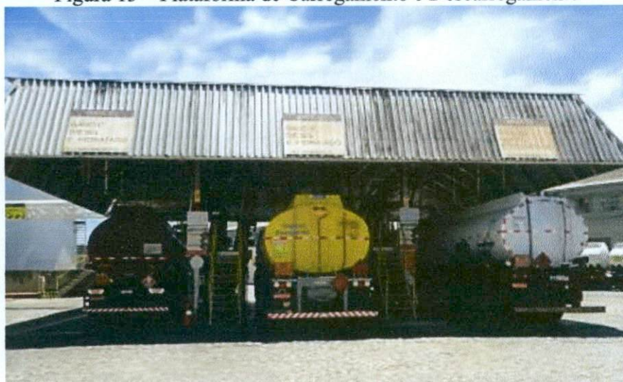
Figura 13 – Plataforma de Carregamento e Descarregamento
