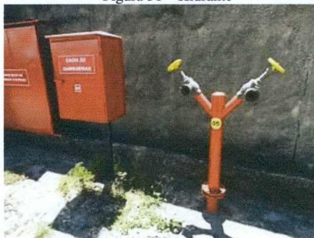
Figura 31 – Hidrante
